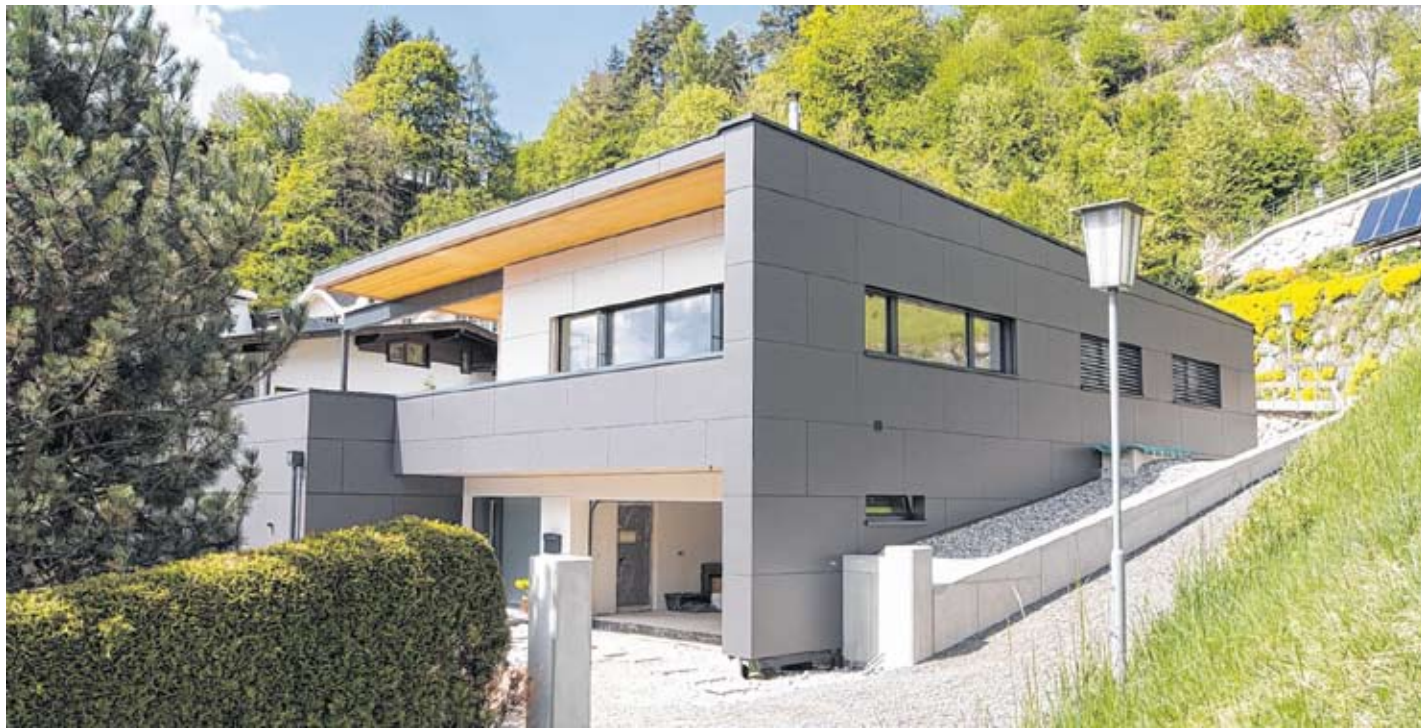
Gut sichtbar heben sich öffnende und schützende Bauteile gestalterisch voneinander ab und lassen Blicke von Innen nach Außen schweifen.
